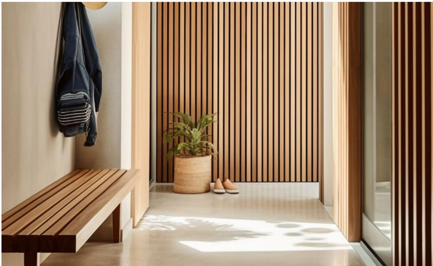
Ce motif de bardage fin est composé de **lattes de 30mm** de large et des **séparations de 12mm**.
